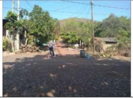
Inicio del andador Allende, se puede apreciar la diferencia de superficie, donde la calle tiene pavimentación en empedrado y cambia a terracería, además de no contar con andador.
