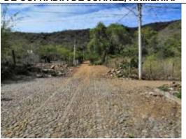
Inicio del andador Torres Quintero, se puede apreciar la diferencia de superficie, donde la calle tiene pavimentación en empedrado y cambia a terracería, además de no contar con andador.
