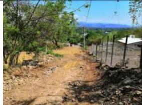
Otra perspectiva, donde se aprecian las condiciones actuales del andador, que aunque se observa en buen estado en condiciones de desgaste por uso normal, no deja de ser un riesgo para los usuarios por el tipo de material en su superficie.
